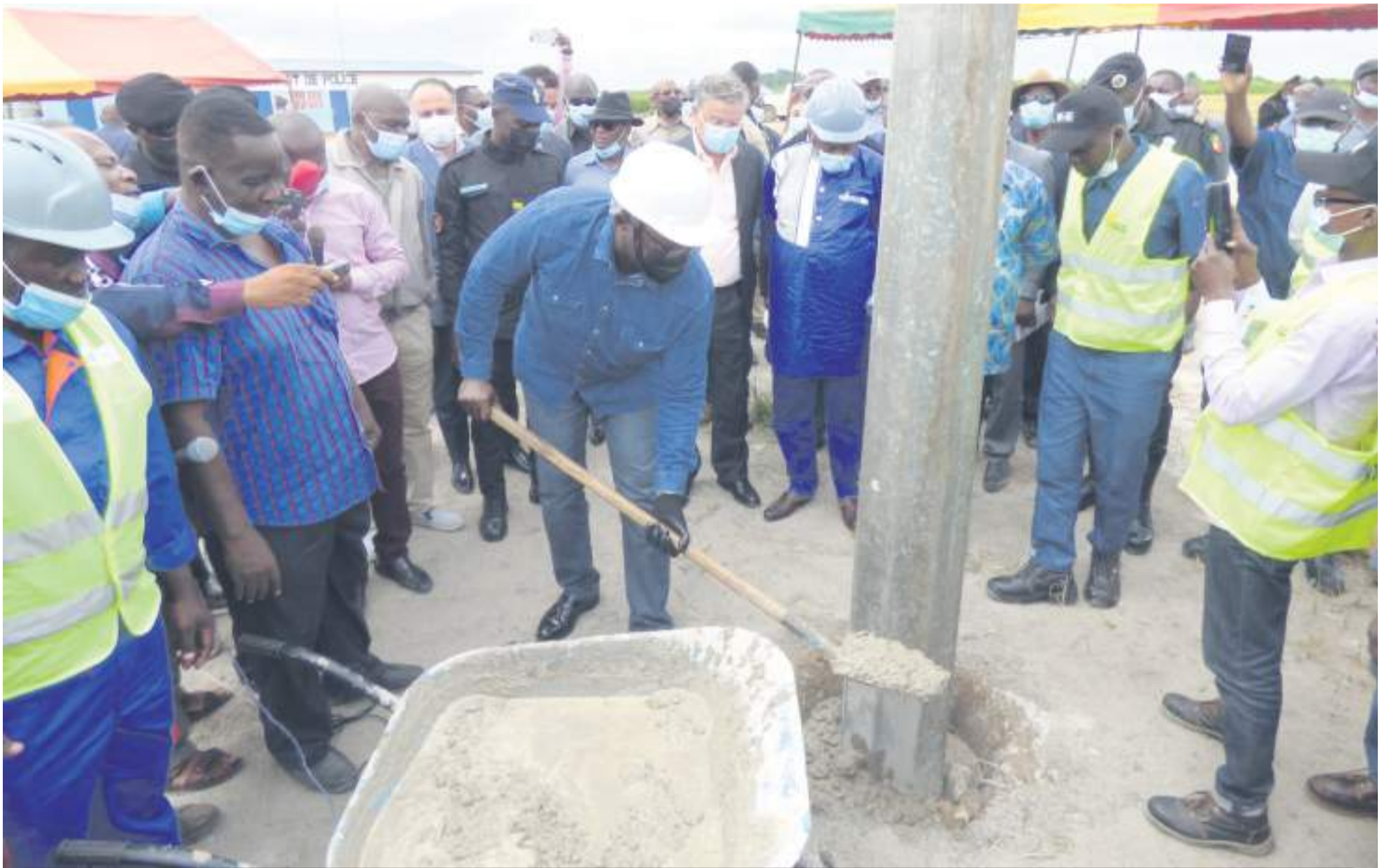
Pose du premier poteau par le Ministre Paul Valentin Ngobo à la Dihessé (Loudima Bouenza)
